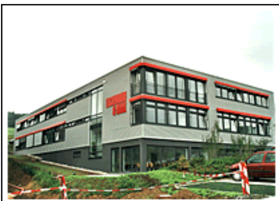
Verwaltungsgebäude in Freudenberg
