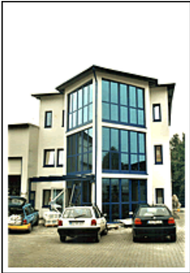
Verwaltungsgebäude in Siegen-Netphen
