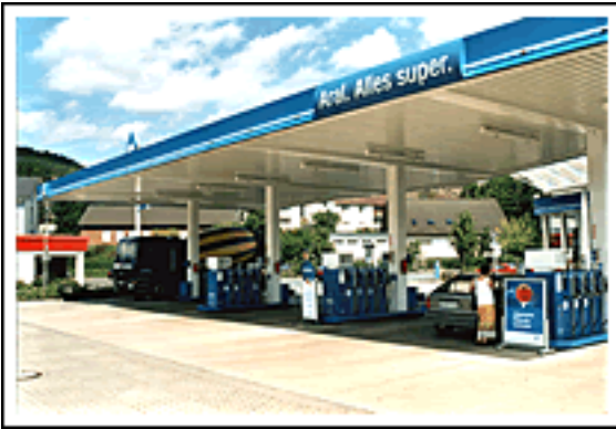
ARAL-Tankstelle (Bad Laasphe)
